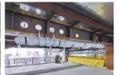
上/消火配管の大梁下での建て方時搬入
