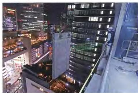
タワークレーンによる外装パネル取り付け状況
