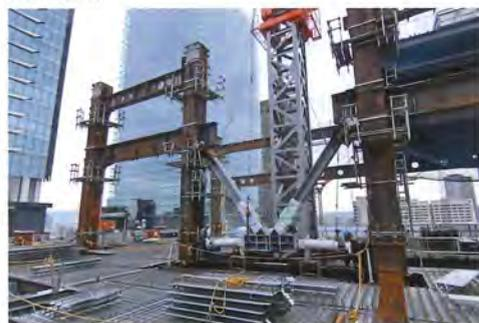
タワークレーンによる鉄骨建て方状況
