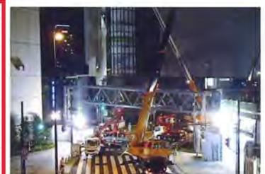
上/消火配管の大梁下での建て方時搬入
