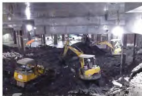
地下エリア 掘削作業状況(床付けまでドライな状態確保)
