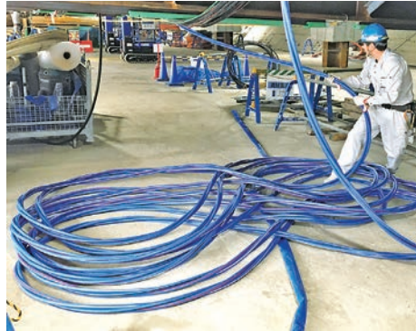
施工時間を大幅に抑えられる「らくらくアルミケーブル」
