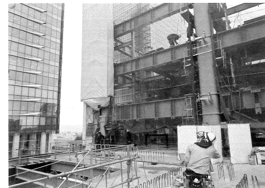
⑯鉄骨建入れ直し時3次元計測システムの利用 精度の確保をすることができた。
