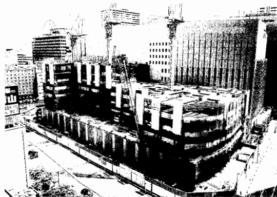
⑨低層部鉄骨建方状況
