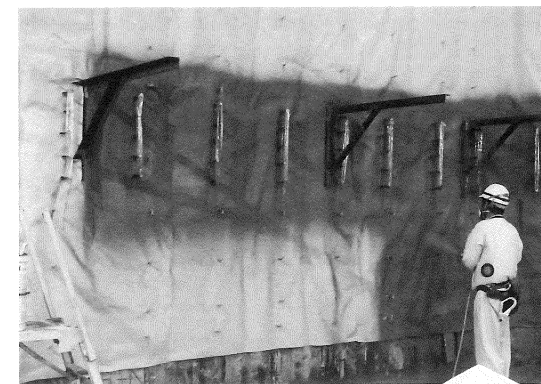
⑦地下外壁防水施工状況
