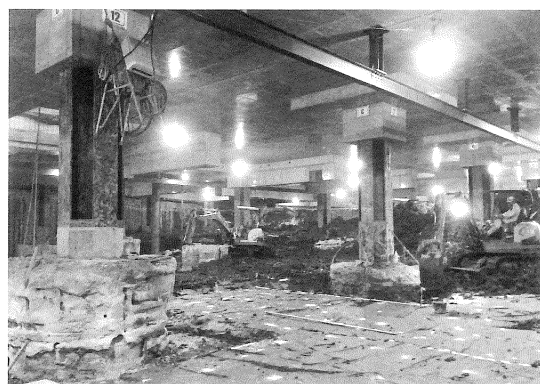
⑥最終掘削・床付状況
