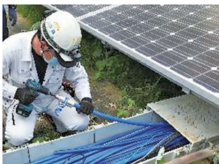
トラフ内での処理作業
