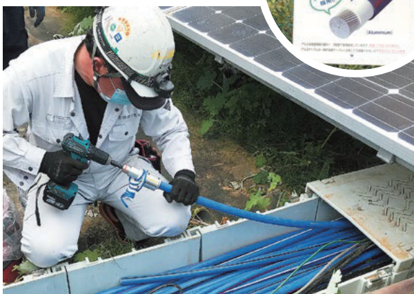
太陽光発電所での接続処理の様子
