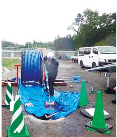
6600kg AL-CVTケーブルの延線作業
