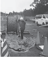
6.6kVアルミニウムCVTの延線
