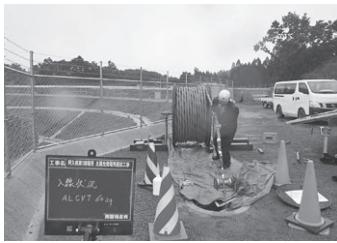
新製品である6600Vアルミ導体CVケーブルを初めて納入し、既存製品の6000Vアルミ導体CVケーブルとあわせて、発電所建設における延線工事の省力化・省人化・効率化に貢献し、約20%の省力化を実現した。
